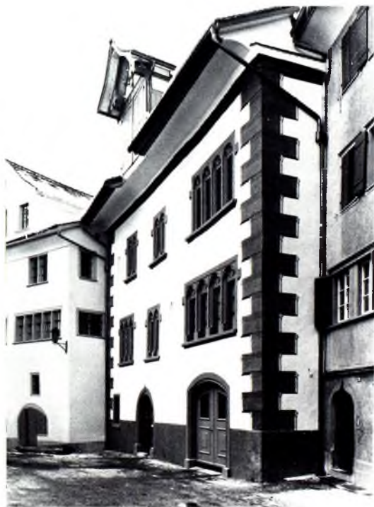
Das alte Rathaus in Lichtensteig kurz nach der Aussenrestaurierung 1968. Die Fenstergruppen mit Blindmasswerk 2. H. 15. Jahrhundert, die Eckquadernbemalung 17. Jahrhundert. Foto Walter Fietz, St.Gallen.
