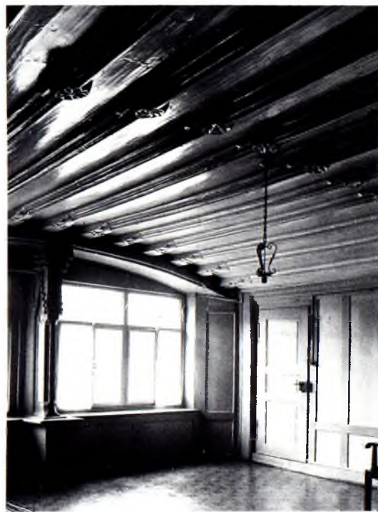
Der grosse Ratssaal im alten Rathaus um 1950. Die spätgotische Bohlenbalkendecke und der sandsteinerner Fensterpfiler sind grau übermalt. Typisches Wohnklima des 19. Jahrhunderts. Foto Dr. B. Anderes.
